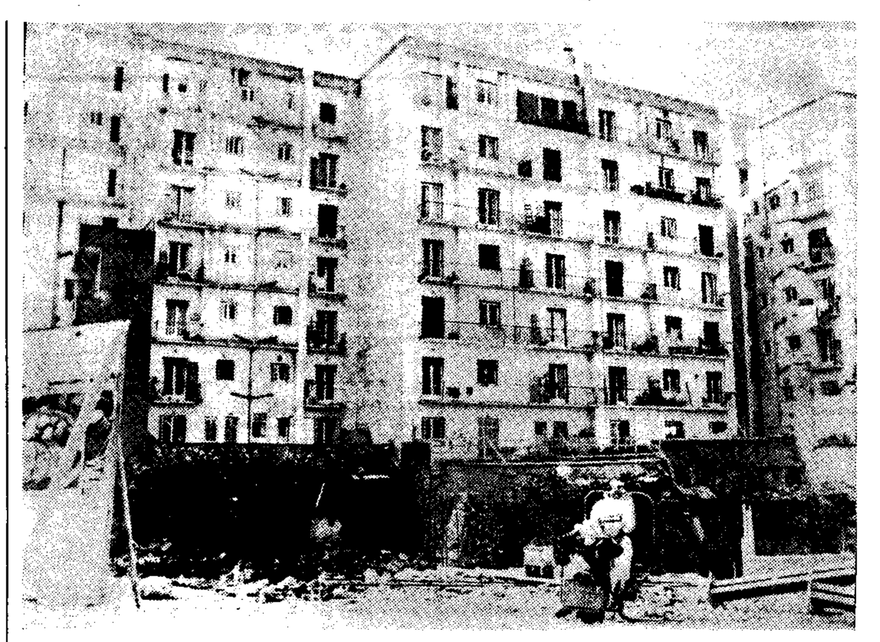
Στὸ κλειδί τοῦ γυμνασίου μοιάζει νὰ εἶναι ἠφαλισμένοι οἱ πολυκατοικίες στὸ τέμα τῆς οδῶ Ἐυφρονίου, στὸ Παγκράτι. Τὰ θεμέλια ἔχουν ἐξυμνηθῆ ἀπὸ τὴν ἀνεργία ἐναποθεῖται, ἕνας τοῖχος παρουσιάζει ρωγμὲς καὶ οἱ ἐπιπορευόμενες λένε ὅτι μπορεῖ ἀπὸ ἄρα σὲ ἄρα οἱ πολυκατοικίες νὰ καταρρεύσουν τὸν κερῆντιον πύργου. Γι' αὐτὸ καὶ ἐγκαταλήφθηκαν ἀπὸ τοὺς ἐνοίκους τὸν.
